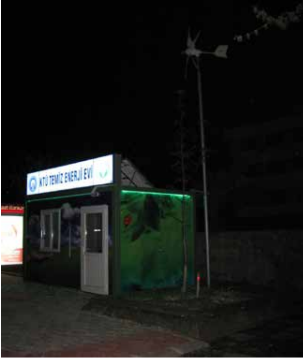
Şekil 6. Enerji kontrol kabini ve temiz enerji evinin gece görüntüsü
