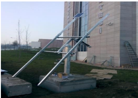
Şekil 3: Güneş takip eden sisteme profillerin montajı
