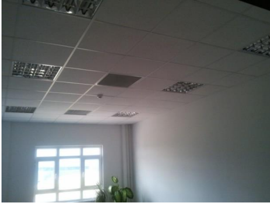
Şekil 2. Oda 1 ve Oda 2 için Flüoresan Armatür Yerleşimi
