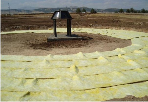
Şekil 2: Güneş Bacası Sistemi Zemin İmalatı [15]
