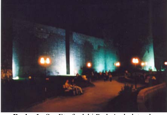
Resim 1a Sur Etrafındaki Park Aydınlatmaları
