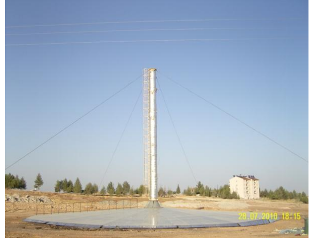
Şekil 4: Güneş Bacası Enerji Santral Prototipinin Bitmiş Hali [15]
