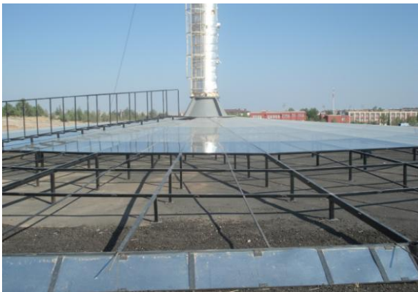
Şekil 3: Güneş Bacası Sistemi Kolektör İmalatı [15]
