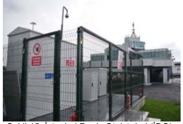
Şekil 15: İstanbul Deniz Otobüsleri (İDO) yakıt pilli kesintisiz güç kaynağı [13]
