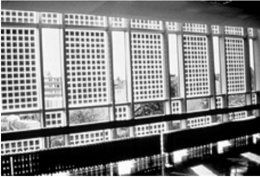
Şekil 13 PV Panellerin Güneş Kontrol Elemanı Olarak Kullanılması (fotoğraf: Courtesy of Kawneer Company, Gordon Schenck, Jr; Courtesy of DOE/NREL, Paul Maycock)
