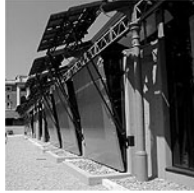
Şekil 14 . Roma Çocuk Müzesi Güney Cephesi Üzerinde PV Modüllerden Yapılmış Hareketli Gölgeleme Araçları
