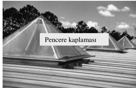
Şekil 4 Tepe Açıklığında Açısal Seçici Cam Uygulaması
