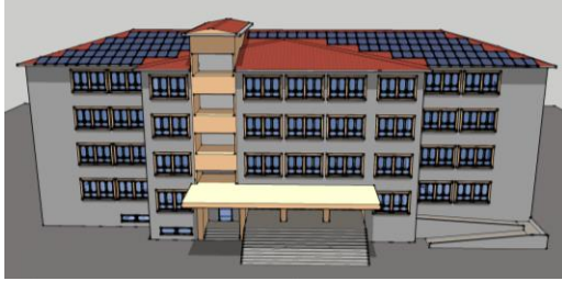
Çatı kaplaması olarak önerilen FV paneller
