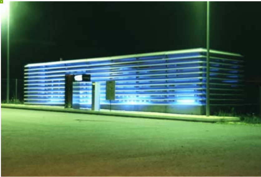
Gaz istasyonu Otelfingen
