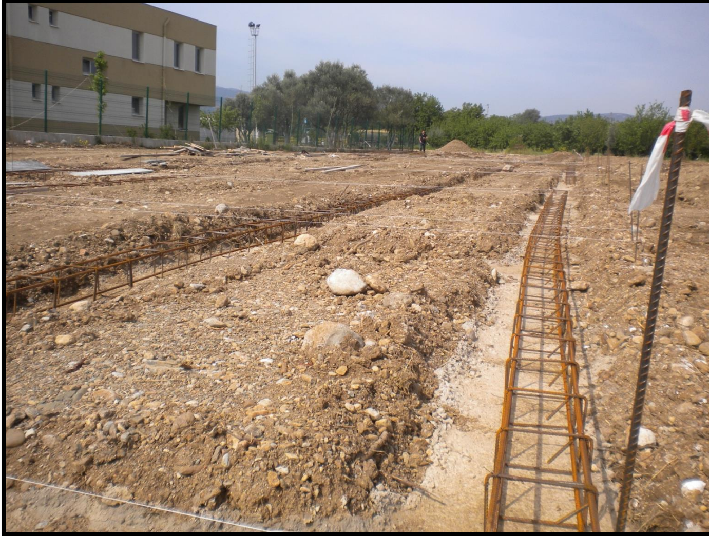
Temel atma hazırlık çalışmaları
