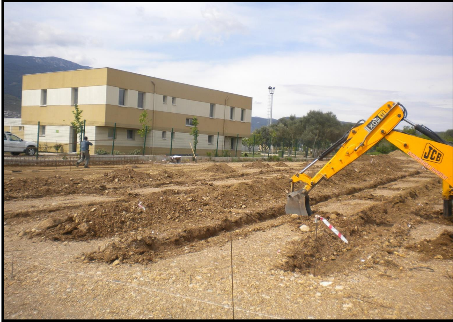
Temel kazı çalışmaları
