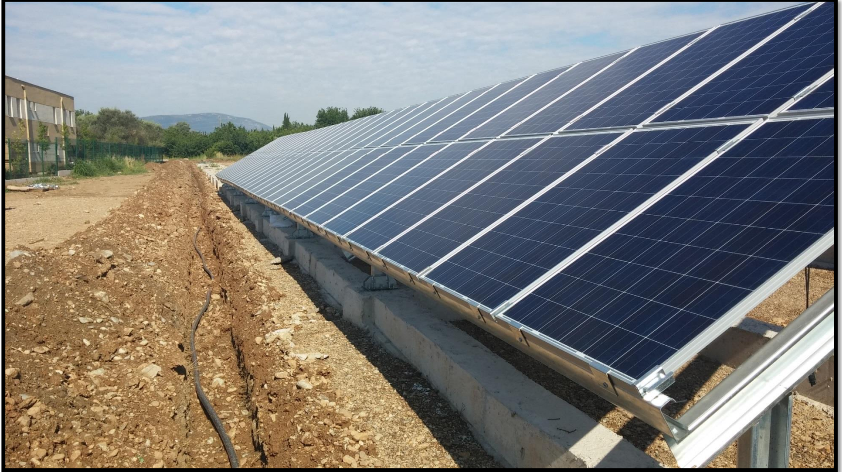
Panel Montaj Çalışmaları
