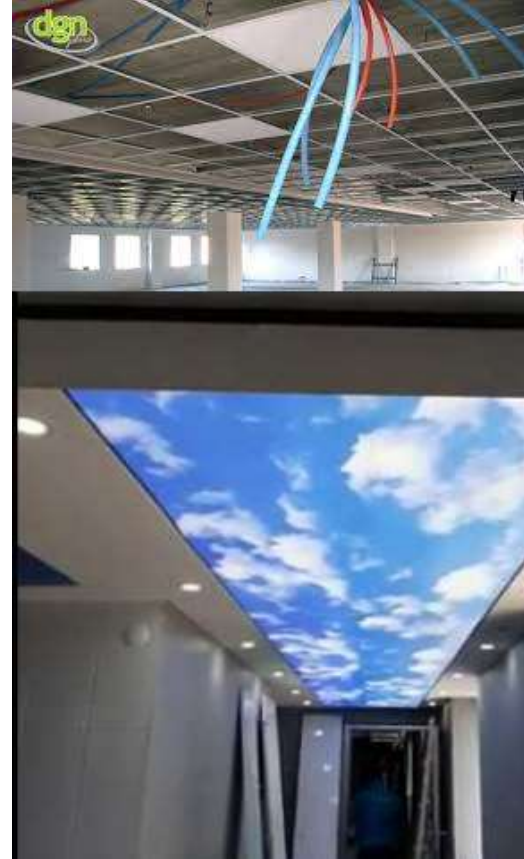
Şekil 8. Asma ve gergi tavanlar
