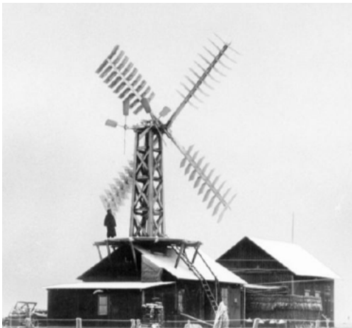
Şekil 2: Paul La Cour’un ilk elektrik üreten rüzgâr türbini, 1891, Danimarka, (Hau, 2006/ Çakır, 2012)
