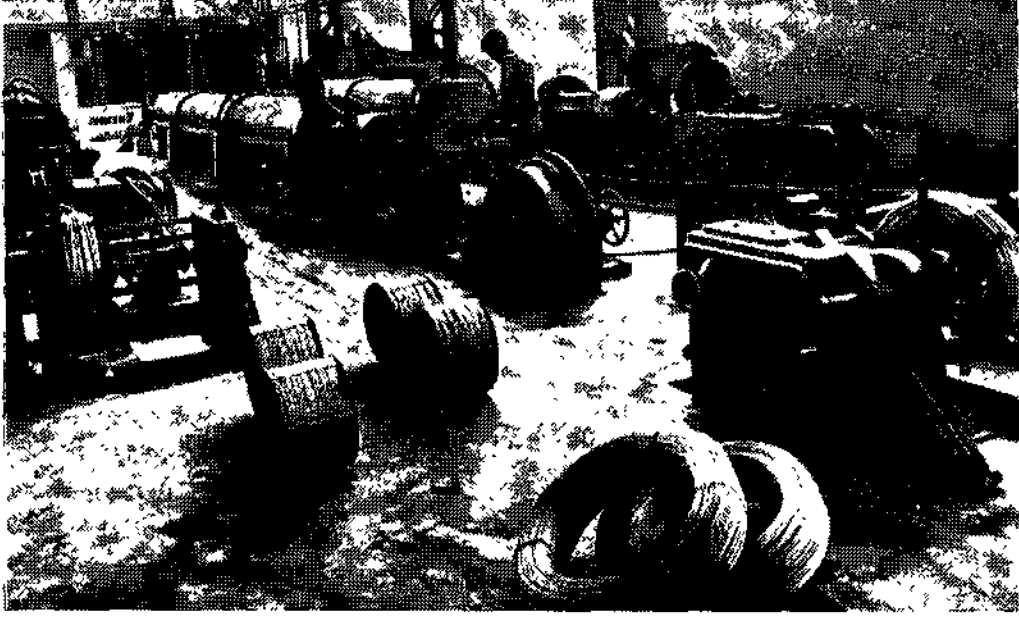
Rabak elektrolitik bakır fabrikası - Tel çekme dairesi.
