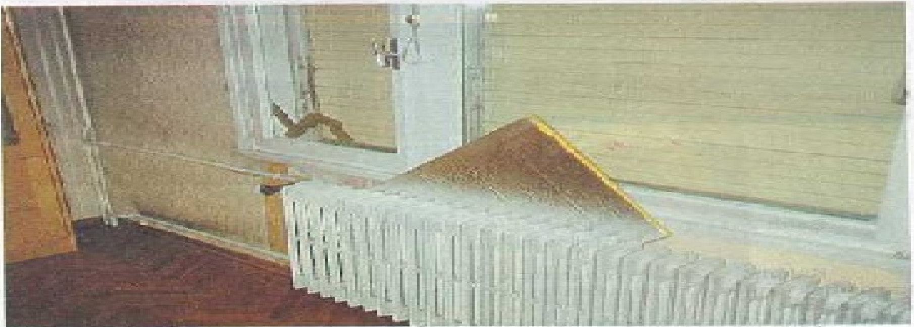
Şekil A-11.2. Radyatör arkasına alüminyum folyo kaplı set
