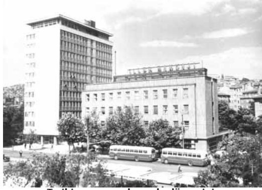
Tarihi yapısı yanbaşıında döneminin "modern!" İller Bankası binası
