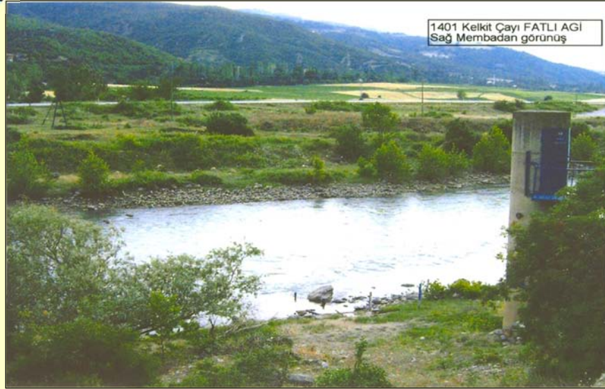
1401 Kelkit Nehri Fatlı AĞI Kule Tesisi
