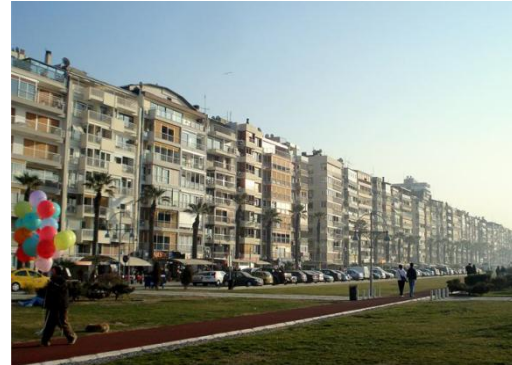
Alsancak-Kordon'da Bitişik Nizam Yapı Yerleşimi
