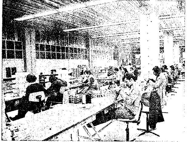
Ar-La Montaj Atölyesinden Bir Görünüş.
