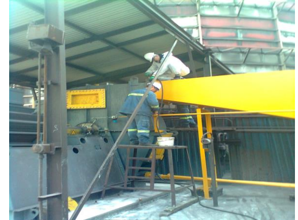
04.03.2014 Fan Körük Bağlantıları
