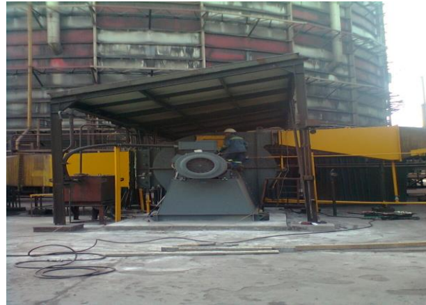
01.03.2014 Fan Kanal Bağlantıları
