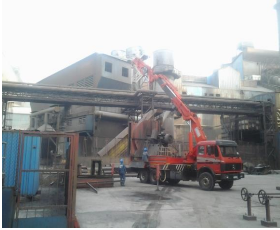
02.01.2014 Mevcut Fanın Demontajı
