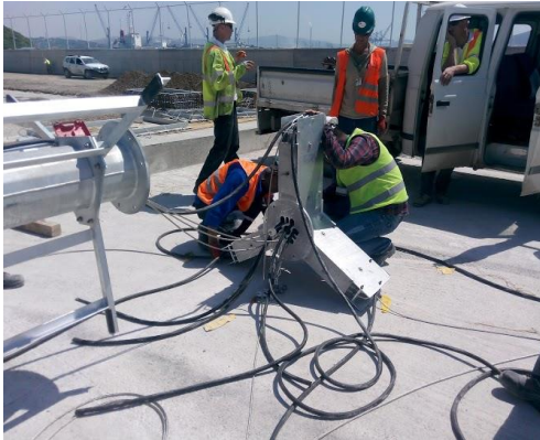
Şekil 6 Armatür platformunun montajı
