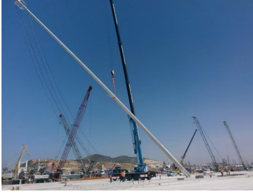
Şekil 7. Aydınlatma direğinin yerine montajı
