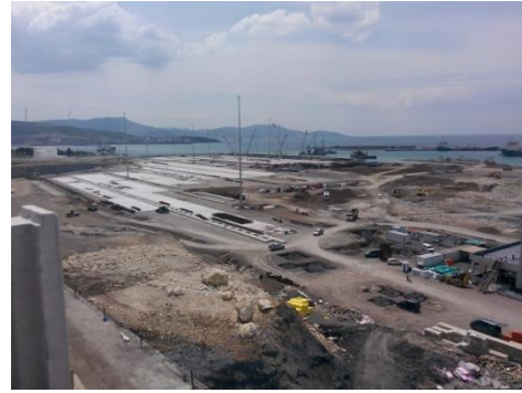
Şekil 3b. Konteyner Depolama Alanı
