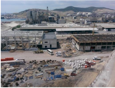
Şekil 3a. Workshop ve İdari Binalar Şantiye Sahası
