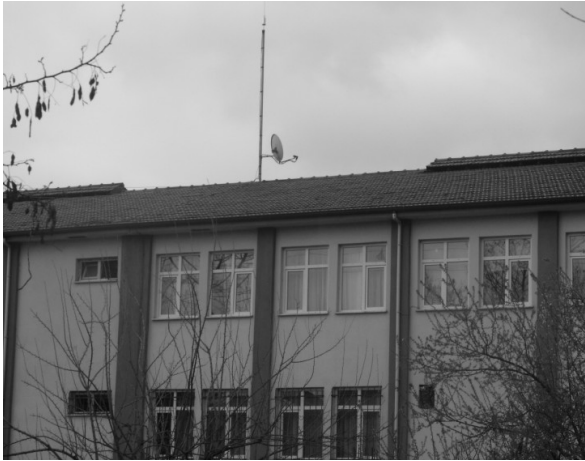
Resim 5. Uydu anten bağlı paratoner korumalı okul
