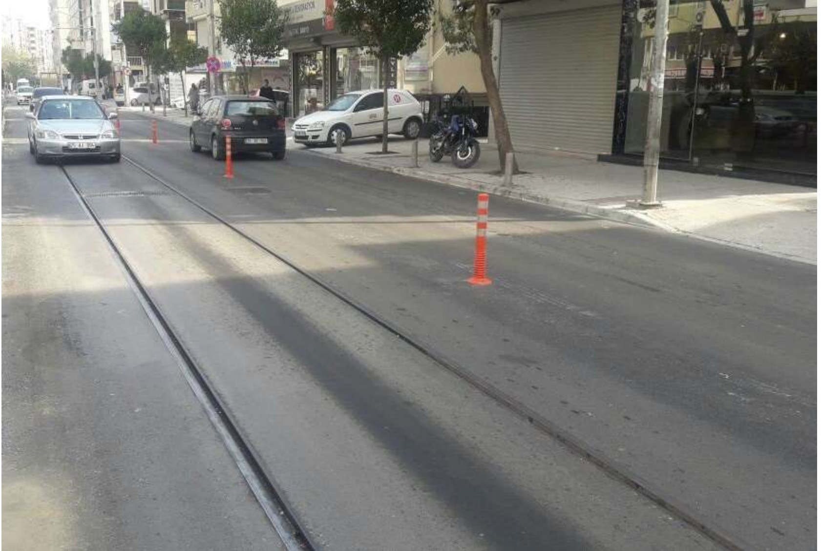
Şair Eşref Bulvarı I. Etap Çalışmaları
