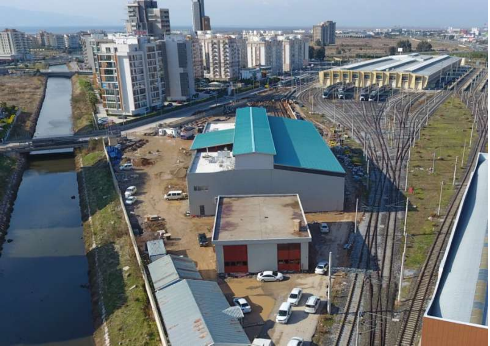
Karşıyaka Tramvayı Depo Sahası
