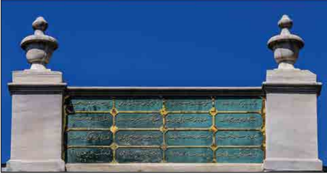
Resim 13. Hendese-i Mülkiye binasının kitâbesi (FSMVÜ arşivi). Hâlen binanın ön cephe ahlığındaki bulunan kitâbe, özgün yerleşimde giriş kapısı üstünde yer almaktaydı. Restorasyon sırasında, buradaki sultan armasının yerine -bu kadar yüksekte okunması mümkün olmayan- kitâbe bloğu yerleştirilmiştir. Celi ta'lik yazıyla yazılmış manzum kitâbenin sol alt köşesindeki tarih mısramın ebced hesabıyla verdiği Hicrî 1302 yılı, rakamla da teyit edilmiştir.
