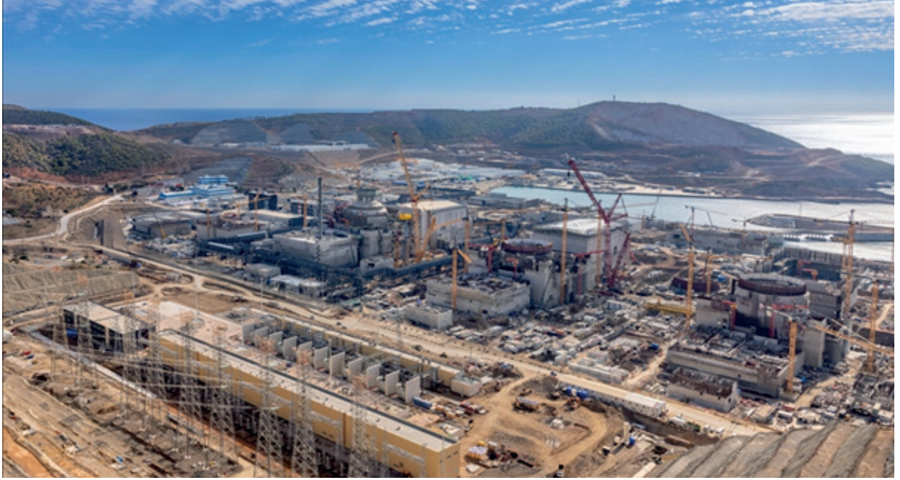
Şekil-30: Fotoğraf: Akkuyu NES inşaat sahası
