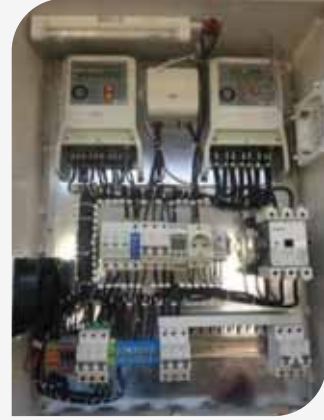
OSOS Numune Pano Montajı
