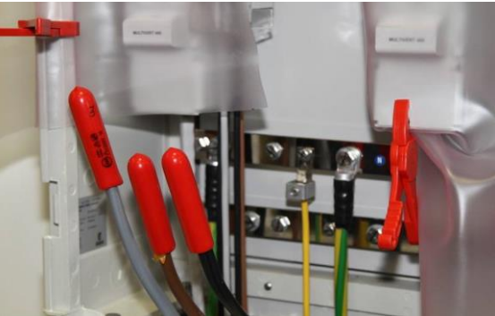
Fotoğraf 4: Şalterin değişimi canlı kablolar izole edilmiş.
