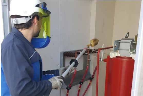
Fotoğraf 3: Enerji varken temizleme yapmak canlı çalışmadır.
