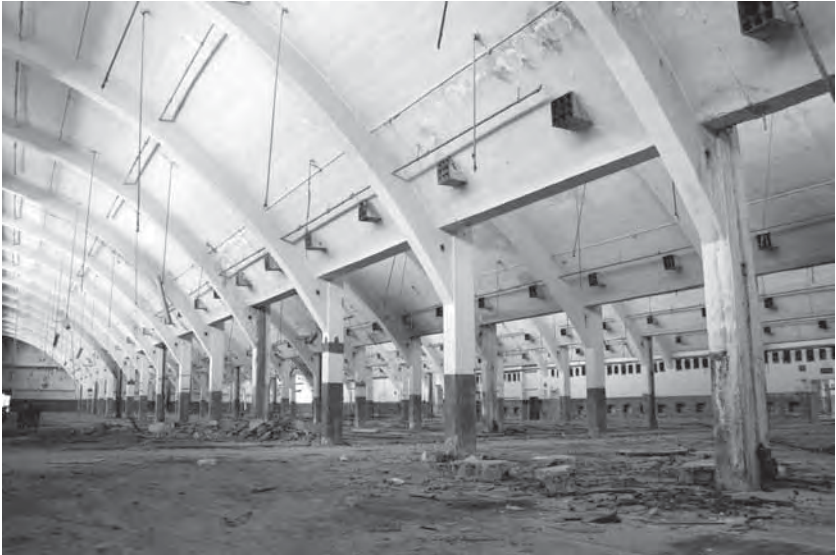
İşletme Binasının İçi, 2011
