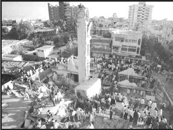
Şekil 9- Deprem sonrası asansör kuyusu kalıntıları
