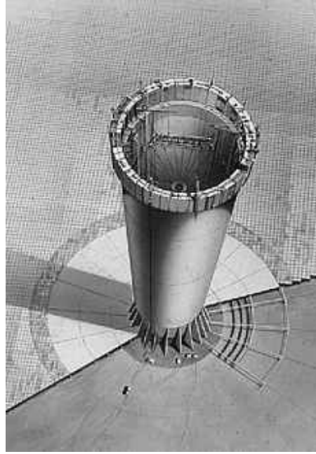
Şekil 4. Bir YHART'nin baca şematik resmi (Schlaich, 1994; http://www.sbp.de ).
