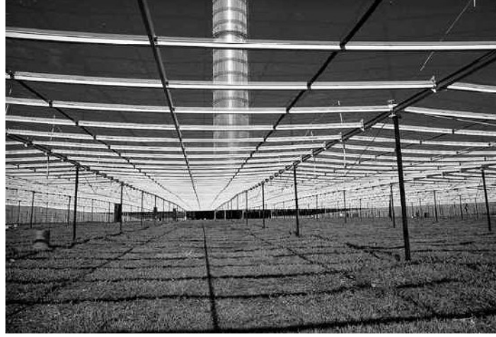
Şekil 3. Toplayıcı içerisindeki görünüş (Schlaich, 1994).
