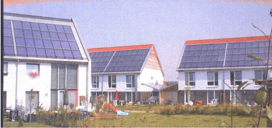
Resim 3: Steinfurt-Borghorst Yerleşiminde çatıya entegre PV uygulamaları
