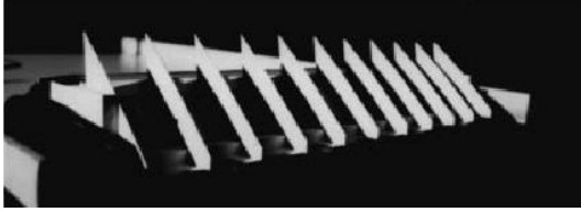
Şekil 6. Anidolik açıklık sistemlerinin çatı uygulaması [2]
