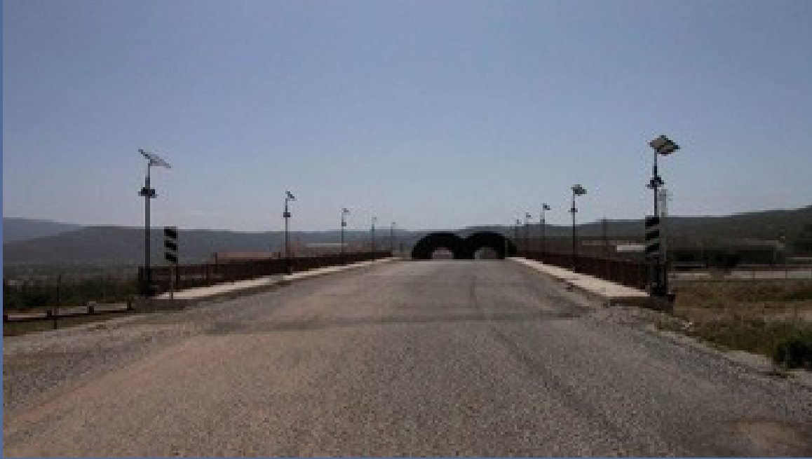
Sıtkı Koçman Köprüsü Muğla
