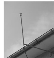
Daha keskin Trafik Merkezine monte edilmiş GPS Anteni
