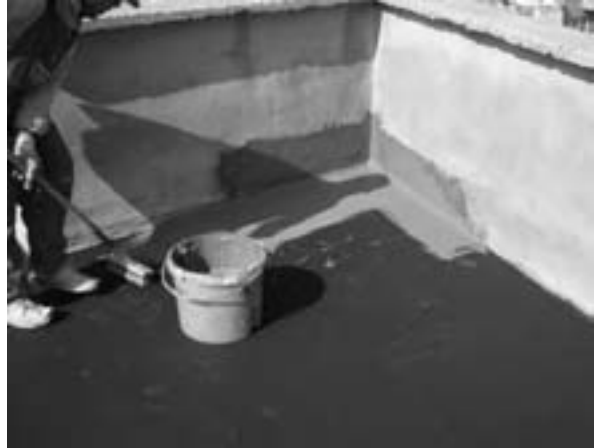
Resim 7 Baz istasyonu altı çatı EM izolasyonu [6]
