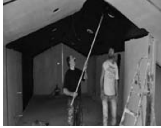
Resim 4 EM kalkanlama boyası uygulanan çatı katı [3].
