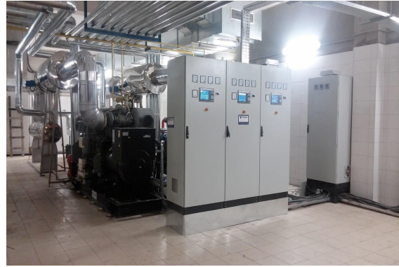
Şekil 7. Edirne Devlet Hastanesi Trijenerasyon Sistemi'nin oda içine yerleşimi
