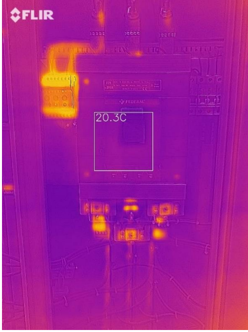
Şekil 5 Arızalı şalter
