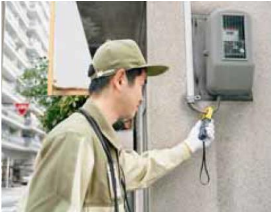
Şekil 2 Kaçak akımın ölçümü
