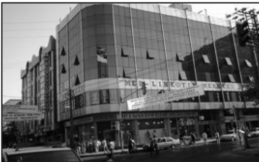
RESİM – 7 Modern iş hanının doğal ışığa cevabı, elektrik kabloları yer üstünden geçiyor, diğer yanlış uygulamalar ile beraber bina estetik görüntüsünden uzaklaşmış.
