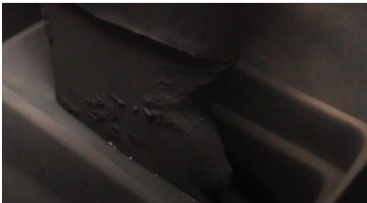
Şekil 23: UFES devrede değilken 100 msn süren bir kısa devre gören bara
