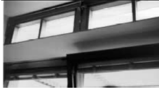
Şekil 4. Pencerenin içine yerleştirilmiş ışık rafı. [3].
