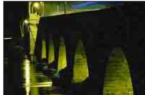
Resim 11. Köprülerden bir görünüş
