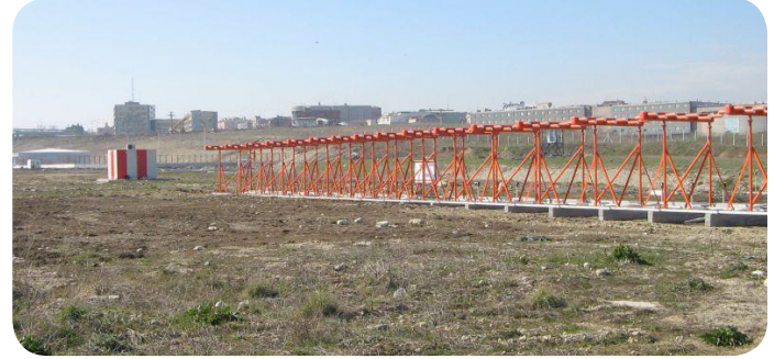
* Şekil 11: Localizer İstasyonu ve Antenleri
