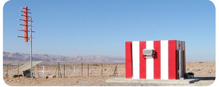
* Şekil 14: Tipik Marker İstasyon ve Anteni
