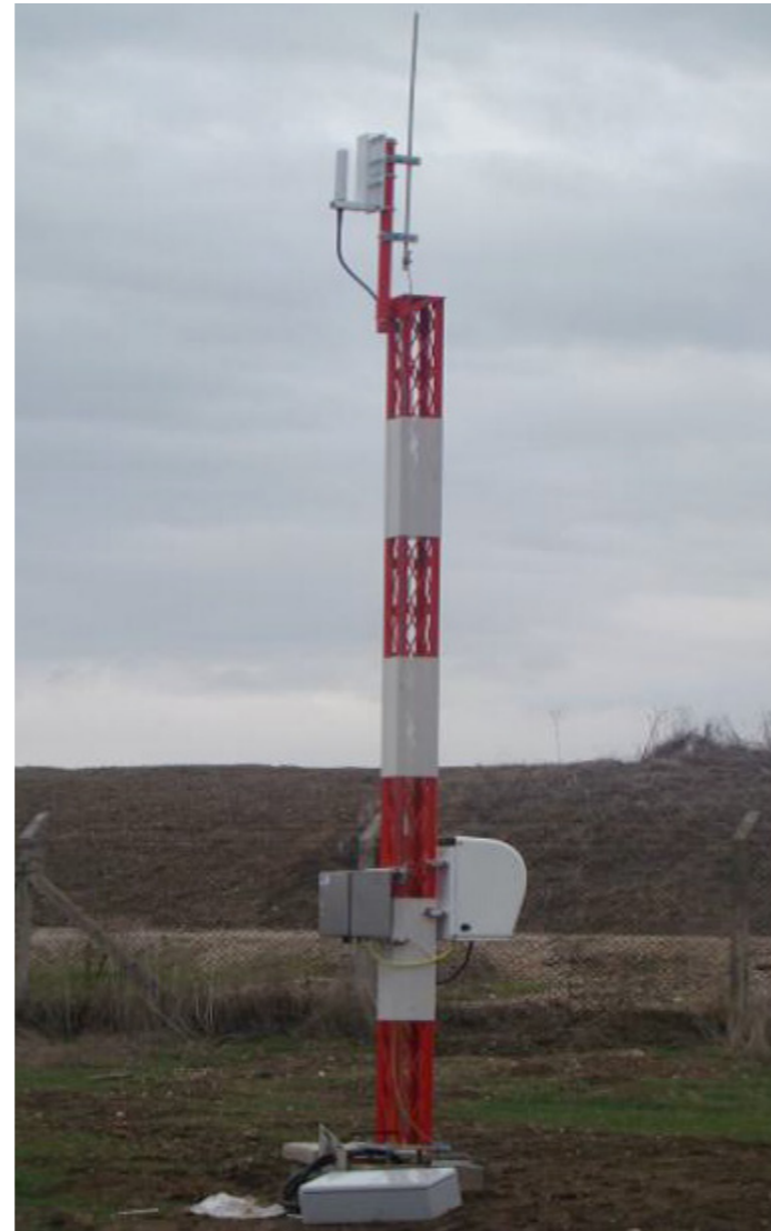
* Şekil-6: DHMİ Esenboğa Havalimanı'nda kurulu MLAT anten istasyonu
