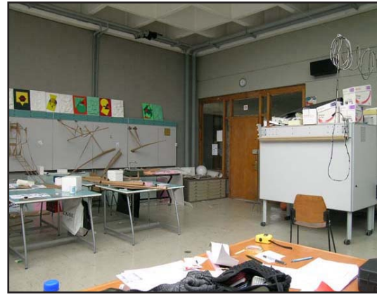
Şekil 9: 34 no'lu atölyeden yer, duvar, tavan görünüşü
