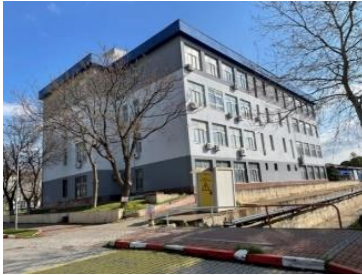
Şekil 3. Ege Üniversitesi İnşaat Mühendisliği binası güney cephe görünüşü.
