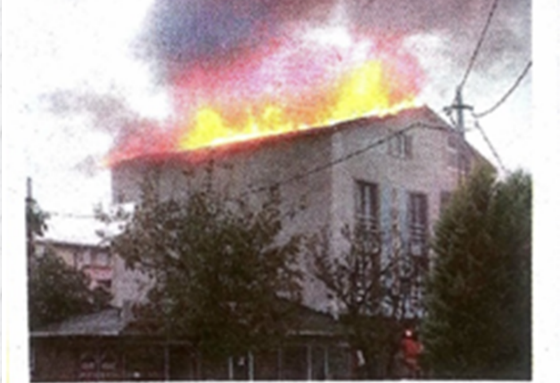
Şekil 7. Yıldırım kaynaklı çatı yangını.
