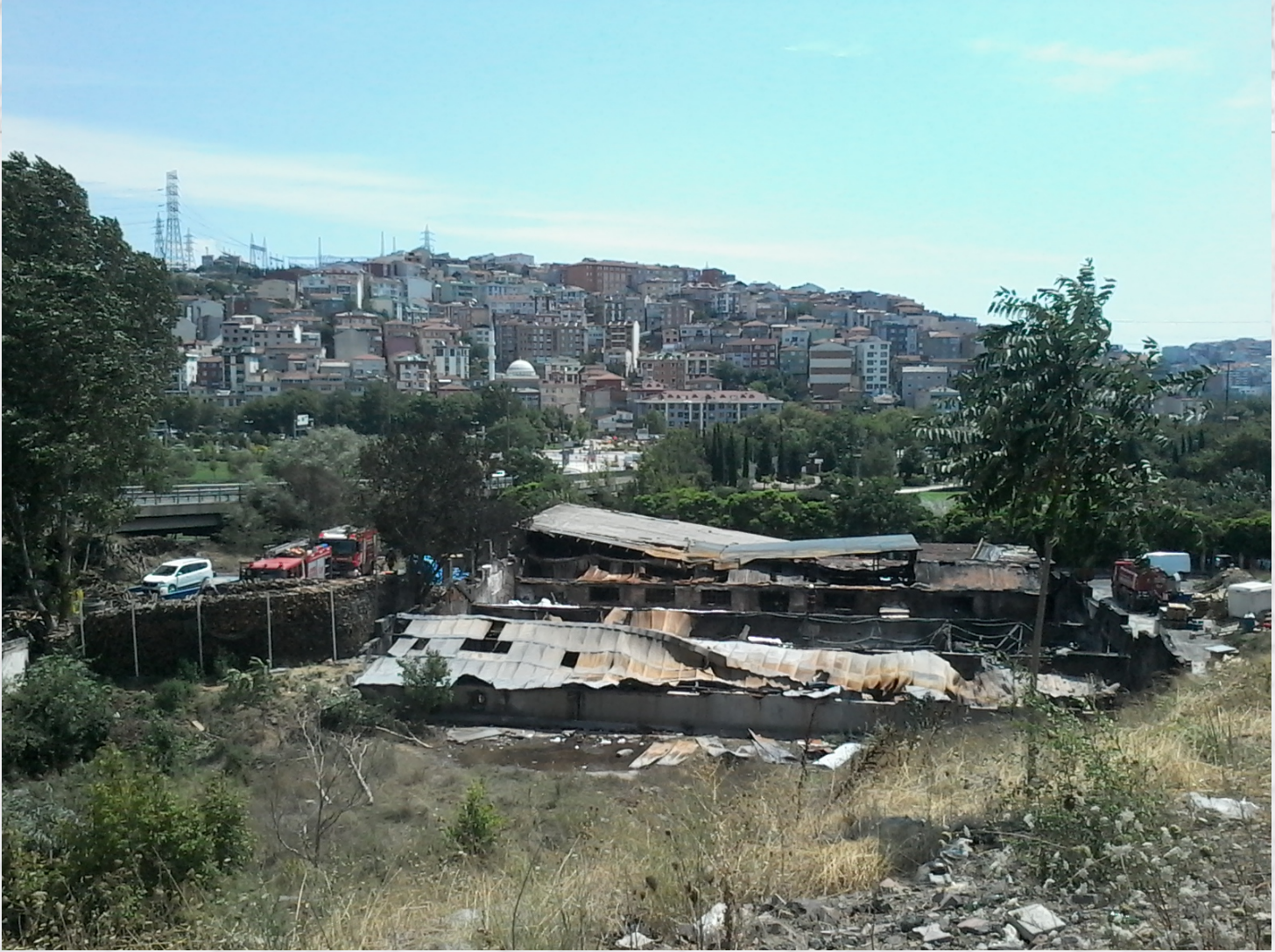
Şekil 5. Odun deposunda yıldırım kaynaklı hasar.
