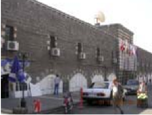
Resim 1. Deliller Hanı Giriş Cephesi
