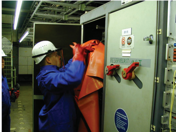
Fotoğraf 4. Canlı Hattın İzole Edilmesi
