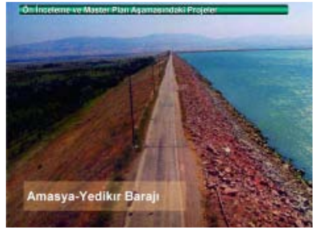
Bu, Amasya'daki Yedikır Barajı'mızdır.
