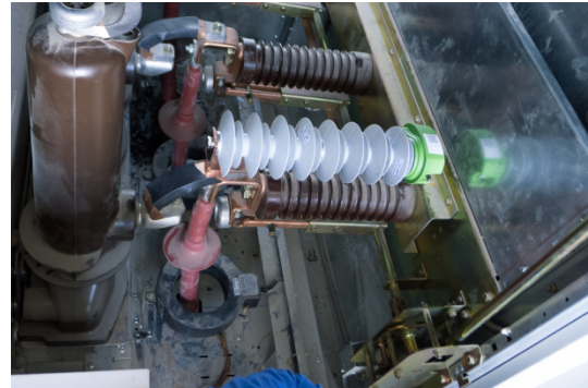
Şekil 5 Coupler cihazının montaj edilmiş hali
